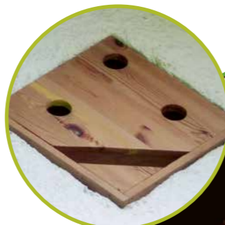
Einflugmöglichkeit für Fledermäuse in den Dachboden
